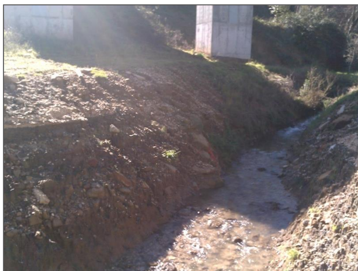
Figura 10 – Ponto de recolha de águas superficiais – Viaduto sobre a Ribeira da Flor – Jusante.
