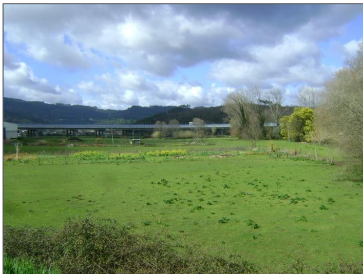
Figura 1 – Ponto de recolha de águas superficiais – Viaduto sobre o Rio Cabra – Montante.
