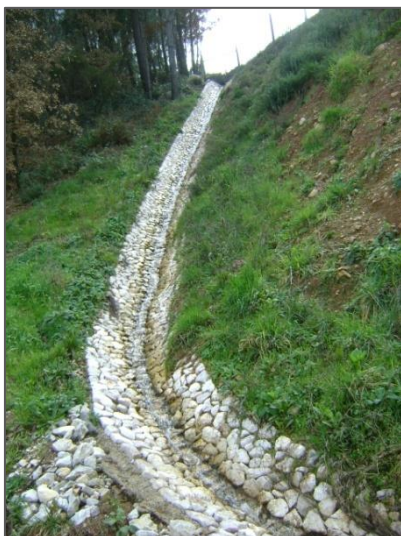
Figura 11 – Ponto de descarga das águas de escorrência da via localizado ao km 2+200
