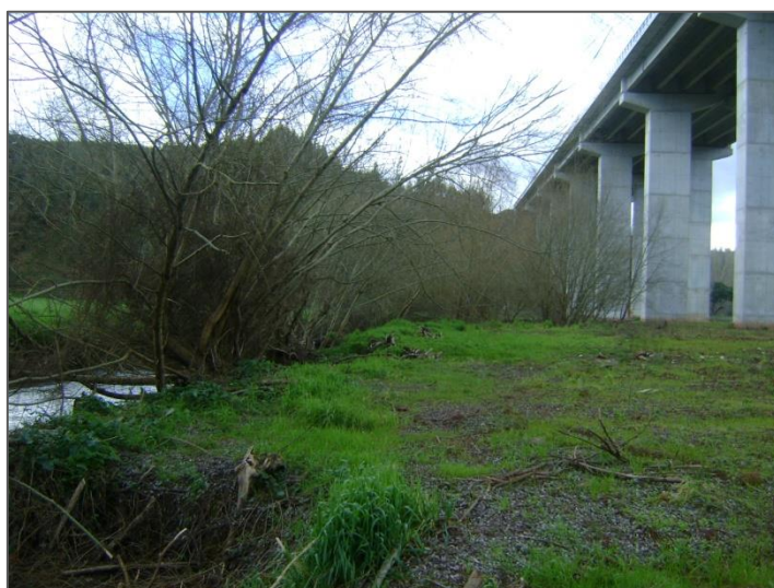
Figura 4 – Ponto de recolha de águas superficiais – Viaduto sobre o Rio Corvo – Jusante.
