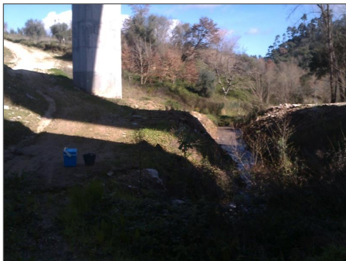
Figura 9 – Ponto de recolha de águas superficiais – Viaduto sobre a Ribeira da Flor – Montante.
