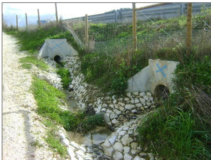
Figura 12 – Ponto de descarga das águas de escorrência da via localizado ao km 12+275
