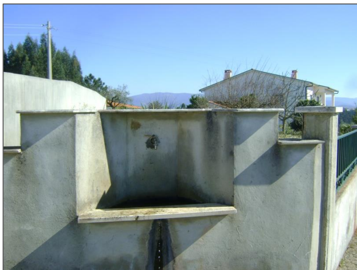
Figura 17 – Ponto de recolha de águas subterrâneas P5, ao Km 15+500.
